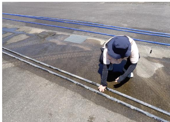
水が出るか、詰まっていないか 確認する
