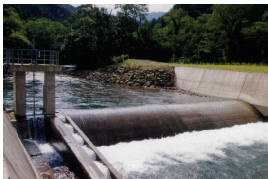
岩前頭首工(大淀川左岸地区)
