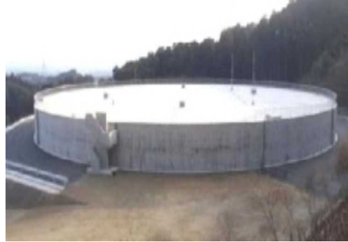
ファームポンドの施工状況
