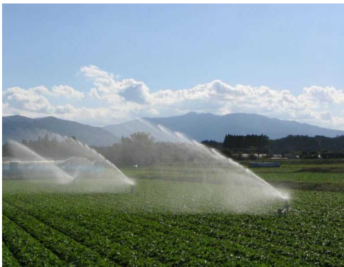
大型スプリンクラー（大淀川右岸地区）
