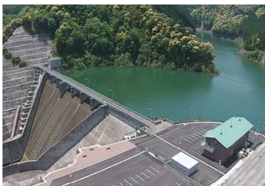
浜ノ瀬ダム(西諸地区)
