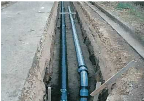
支線水路の施工状況
