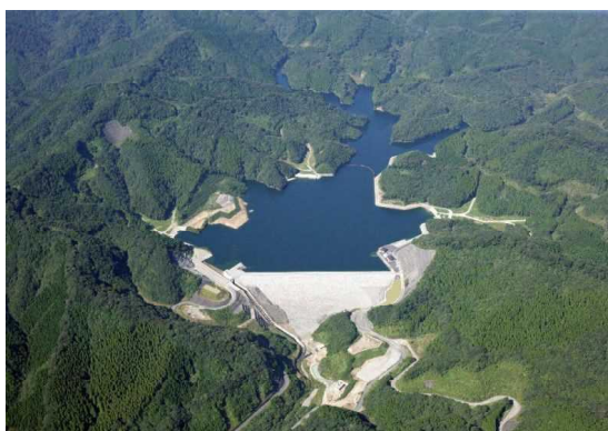
木之川内ダム(都城盆地地区)
