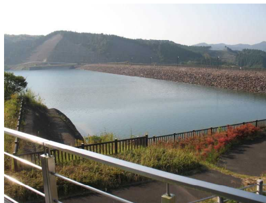
天神ダム(大淀川右岸地区)
