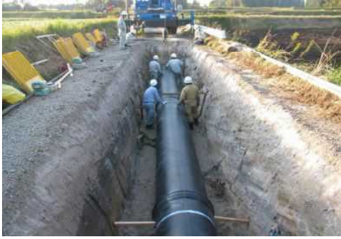
幹線水路の施工状況
