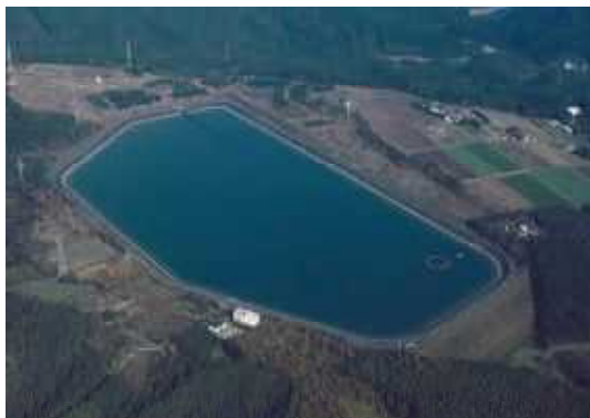
東原調整池(一ツ瀬川地区)
