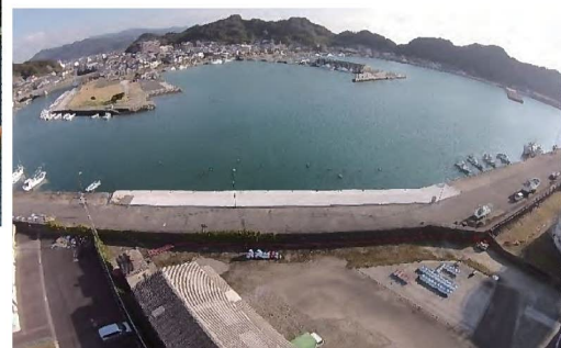
水産物供給基盤機能保全事業による物揚場の老朽化対策工事（油津漁港）
