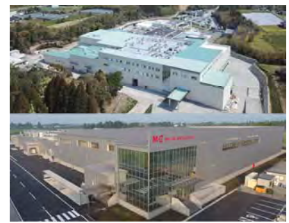
輸出拠点施設の整備
