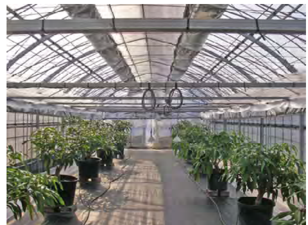
【内張りカーテン巻き上げ時】
