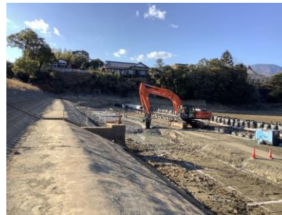
図23 ため池対策工事
