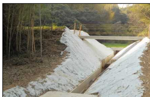
廃止ため池：掘り割った堤体
