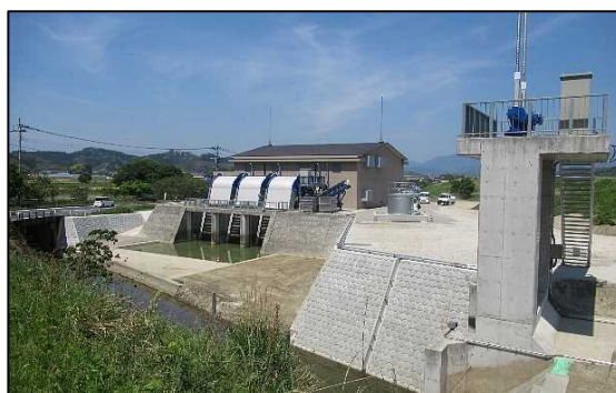
排水機場：河川へポンプで排水
