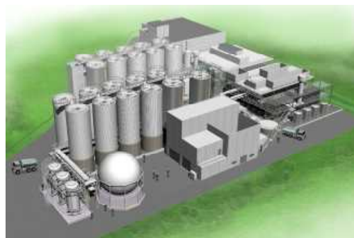
1日最大800tの焼酎粕を処理する 国内最大級のリサイクルプラント
