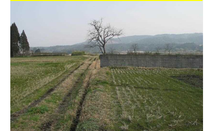
用・排水路兼用(土水路)
