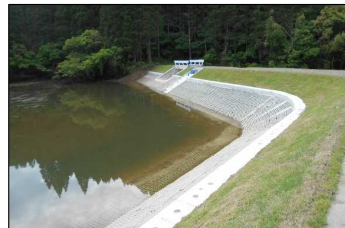
ため池の改修整備
