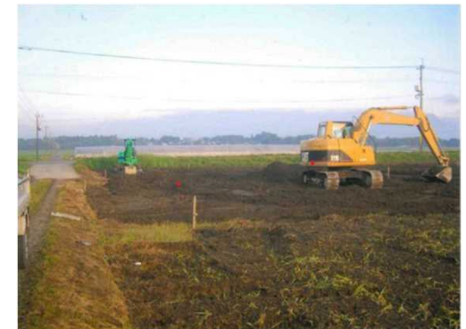
畦畔除去・整地工
