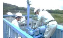
・水門等の施設診断
