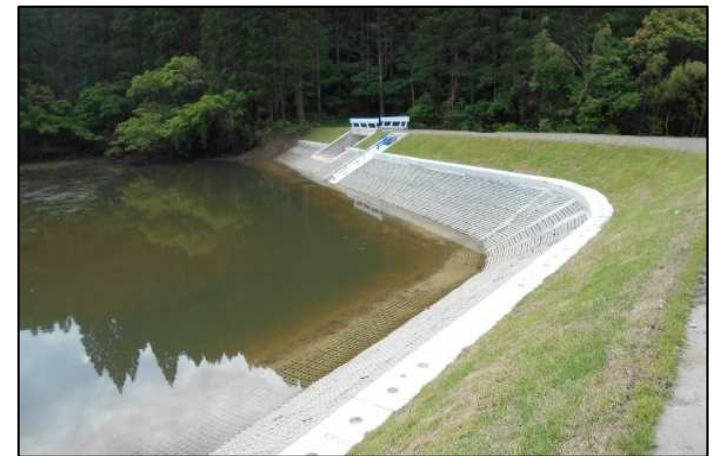
ため池の改修整備
