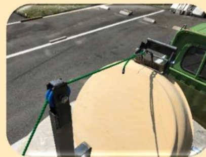
滑車式遠隔開閉タンク蓋
