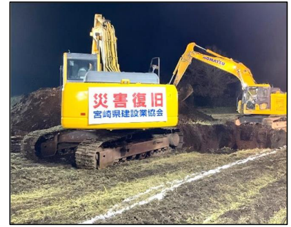
R6年度 高病原性鳥インフルエンザ発生時の掘削作業
