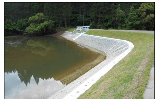
ため池の改修整備
