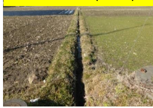
用・排水路兼用(土水路)
