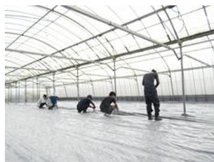
(ビニルの継ぎ目をホッチキス留め)
