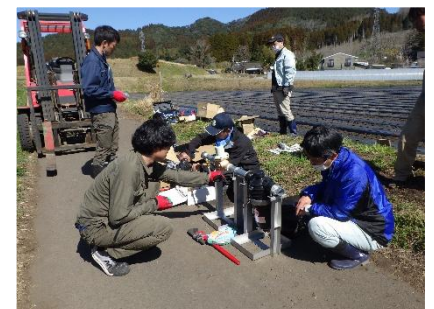
【散水器具設置の様子】
