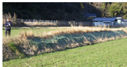
【メーカーとの点検】
