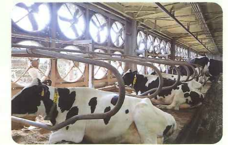
壁一面の給気・換気ファン
