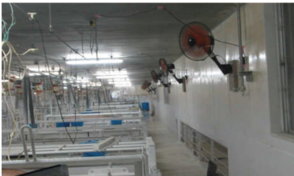
写真1 壁掛扇風機6台
