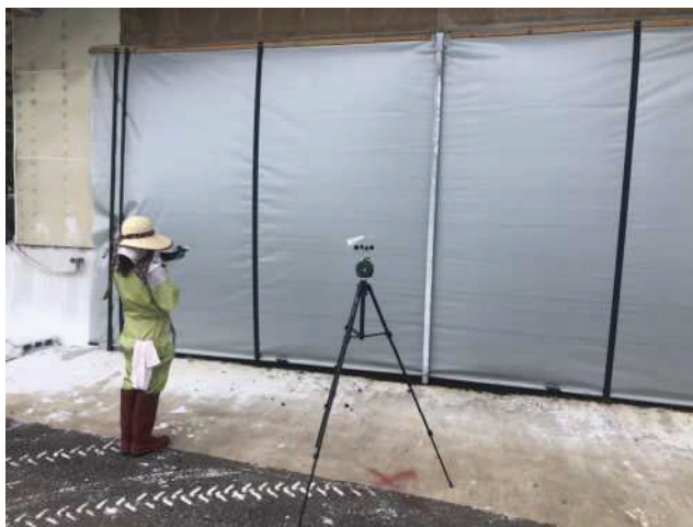
写真1 簡易な臭気低減対策（堆肥化处理施設）
