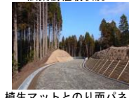
植生マットとりのり面パネル
