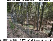
侵入防止柵（ワイヤーメッシュ）
