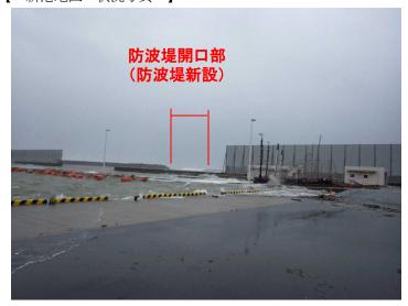
・防波堤の開口部から進入する波浪の 影響により、新港地区の静穏性が損 なわれている。
