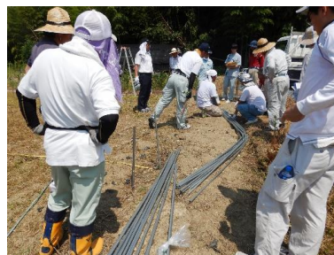
災害復旧の取組実証
