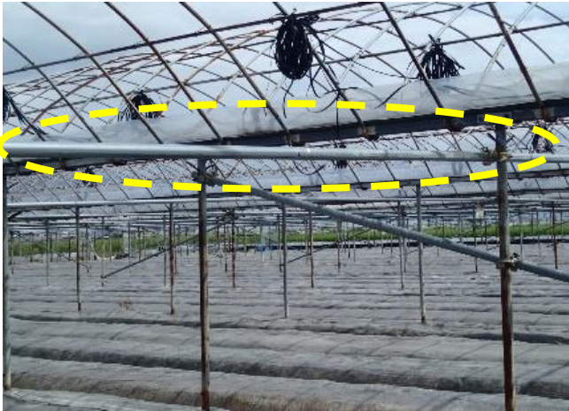
タイバーの設置による補強
