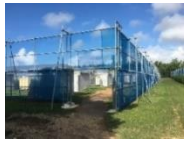
防風ネットの設置
