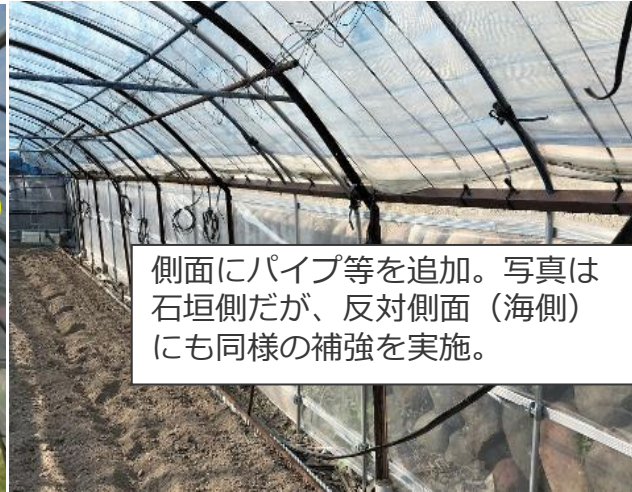
側面の補強（強風対策）
