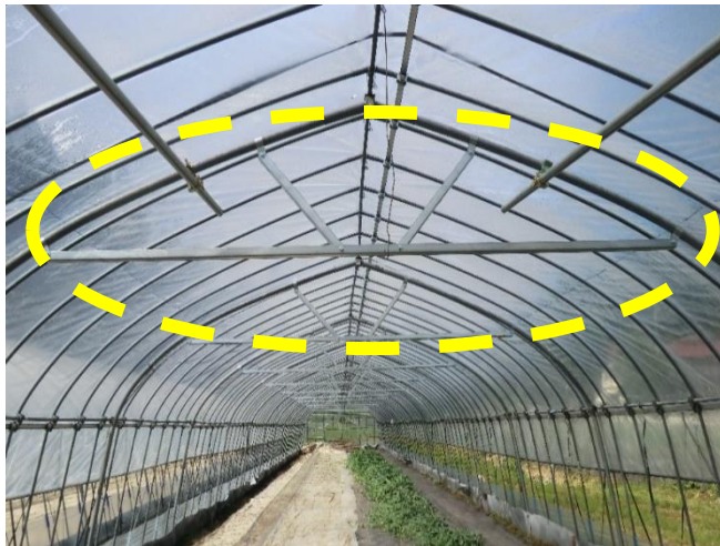
タイバーの設置による補強
