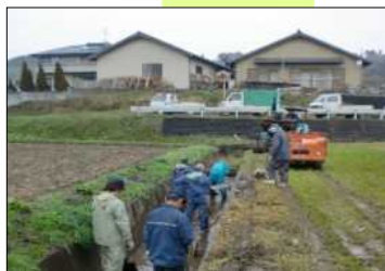
水路の維持管理
