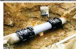
漏水防止のための整備
