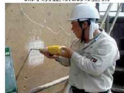
老朽化した施設の機能診断
