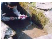
水路のひび割れ補修
