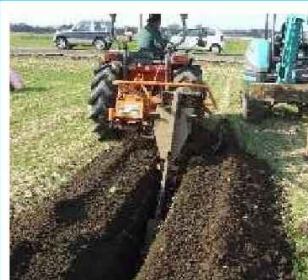
暗渠排水の整備
