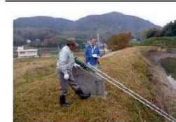
ため池の現地パトロール
