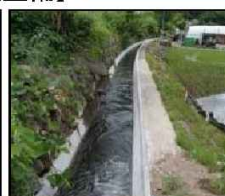
老朽化した用水路の整備・更新
