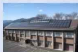
地域資源活用施設 （太陽光発電施設）
