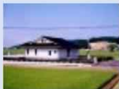
農業集落排水施設
